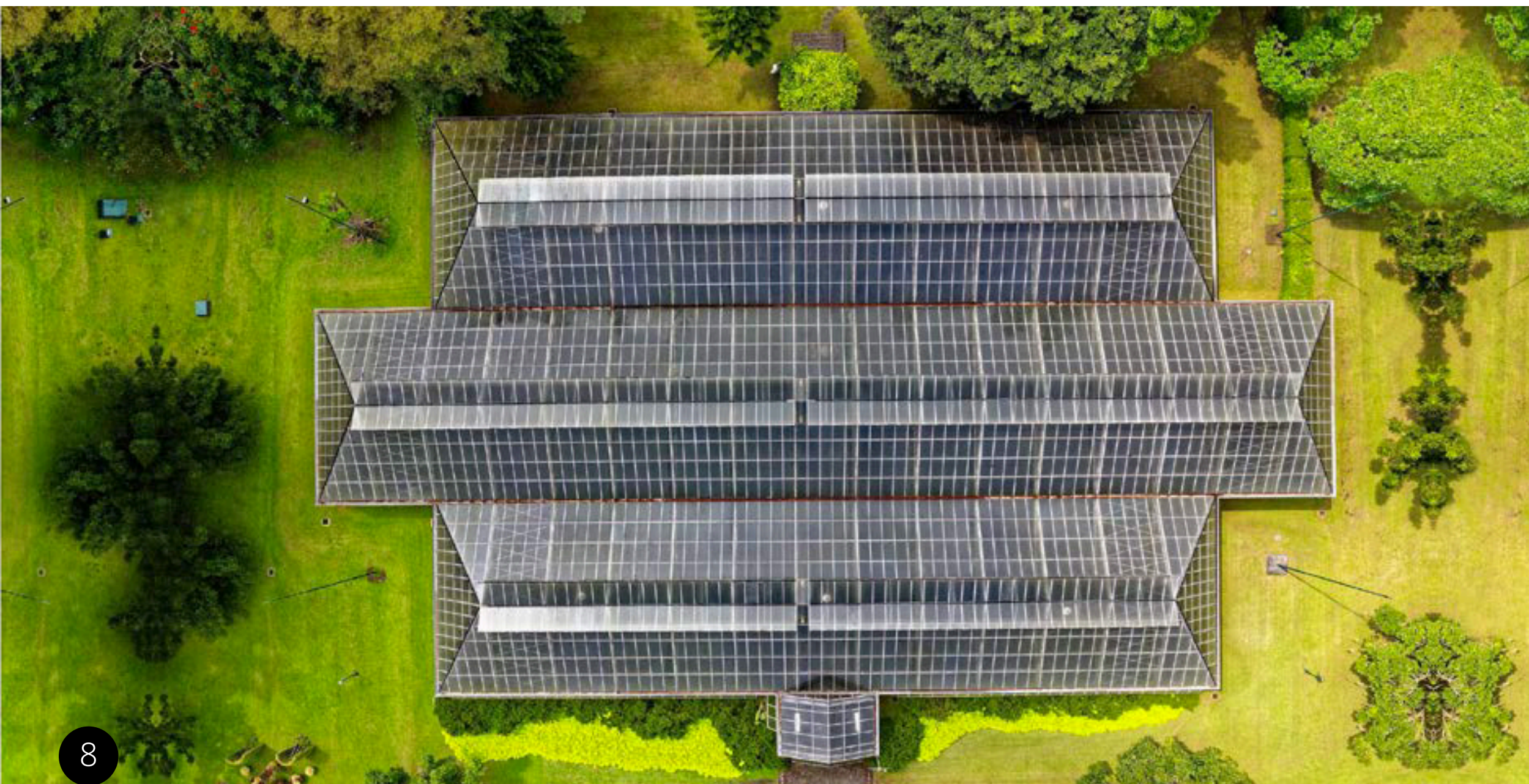
Techo con paneles solares en Sukaresmi, Indonesia
